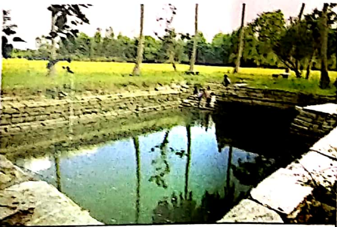
अलवर, राजस्थान में बनाए गए लघु तालाब जहां वर्षाजल संचयन से 1500 परिवारों के लिए जलापूर्ति होती है।
