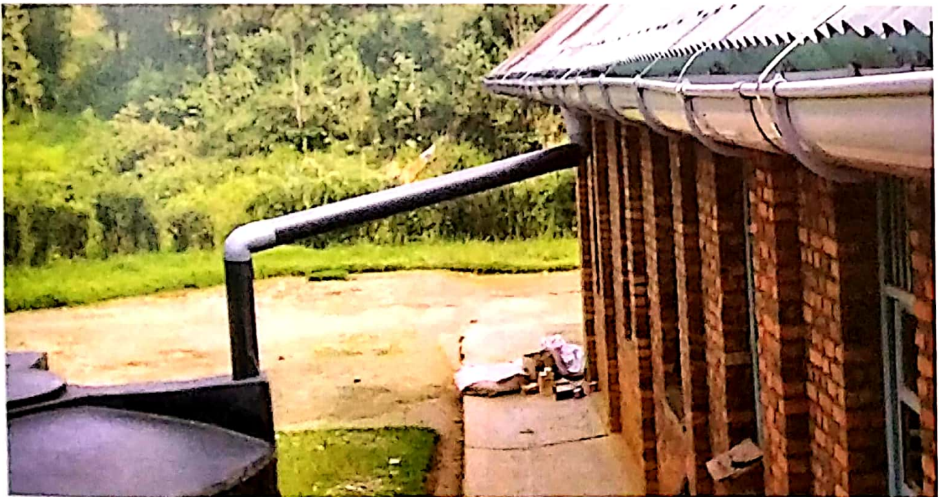
छत पर पाइप के माध्यम से वर्षाजल संचयन — रूफटॉप रेन वॉटर हार्वेस्टिंग
